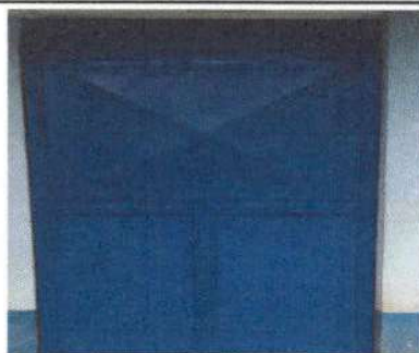
Foto 3: Sustitución de portón de madera por metal.
