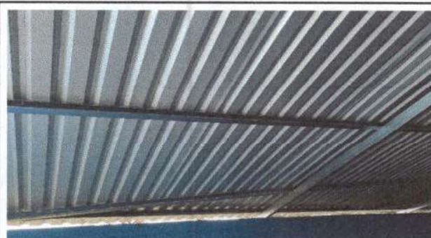
Foto 4: Sustitución de estructura de madera por metal y lámina en el corredor de la escuela y cocina.
