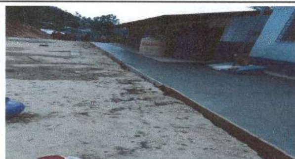
Foto 5: Sustitución de piso de torta en el corredor de la escuela.
