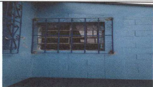
Foto1: Fabricación e instalación de balcones en mpdulo.
